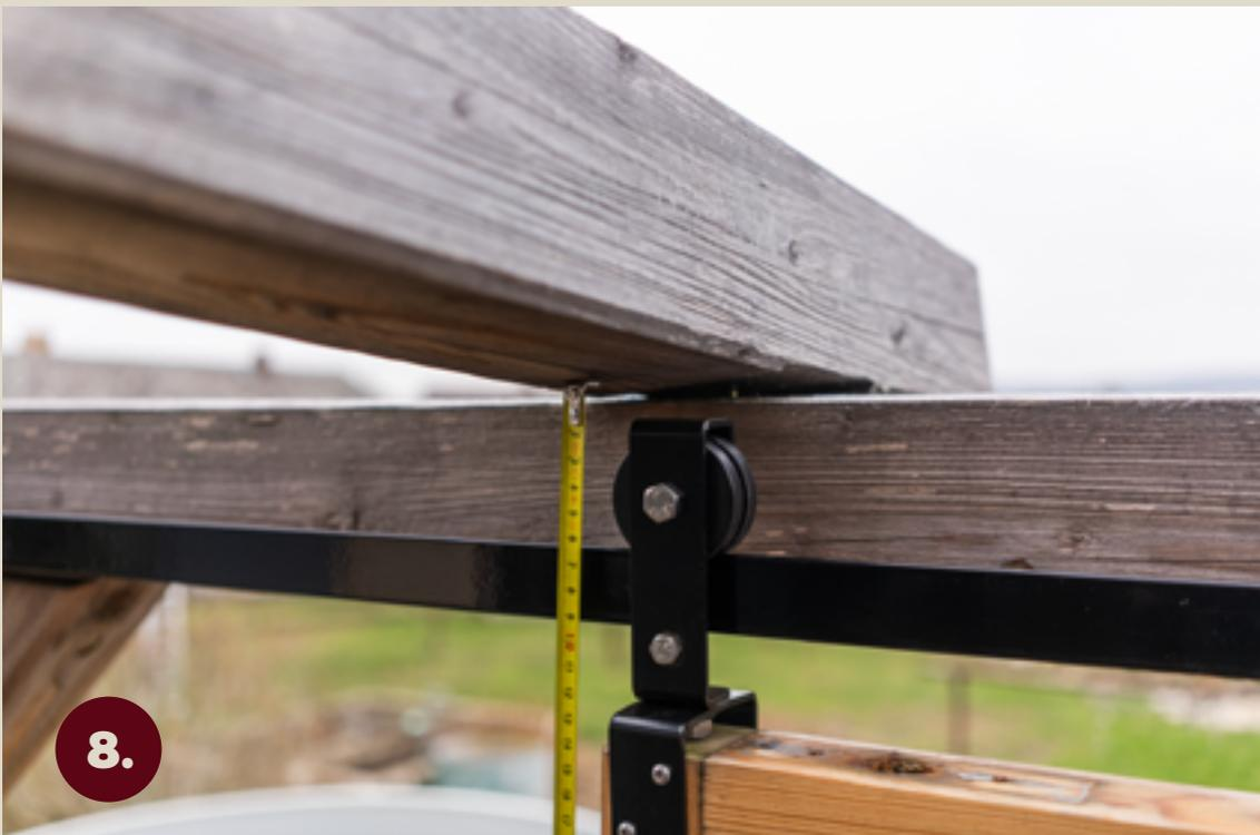
Bereiten Sie die Schienen vor und befestigen Sie sie mit Schrauben an der Pergola. Über der oberen Kante der Schiene muss mindestens 5 cm Platz sein, damit die Rolle ohne Unterbrechung durchfahren kann.
