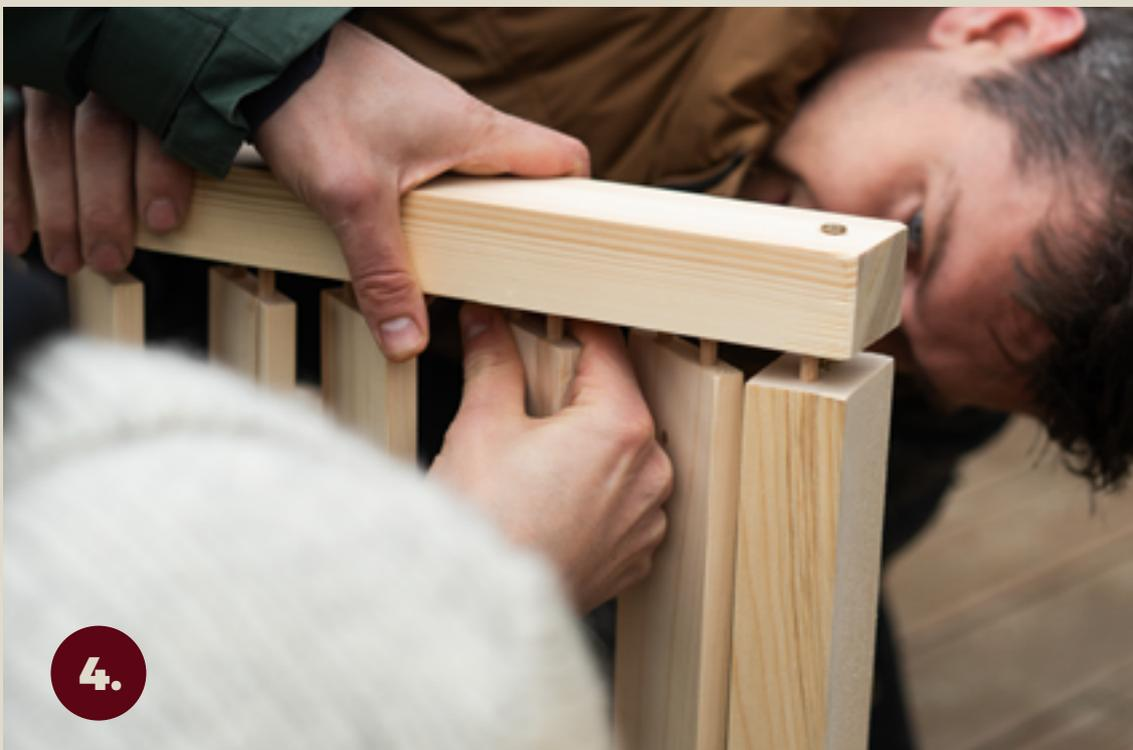
**4.** Setzen Sie die andere Seitenwand auf und befestigen Sie sie teilweise mit der mitgelieferten Schraube von einer Seite (nicht bis zum Maximum anziehen).
