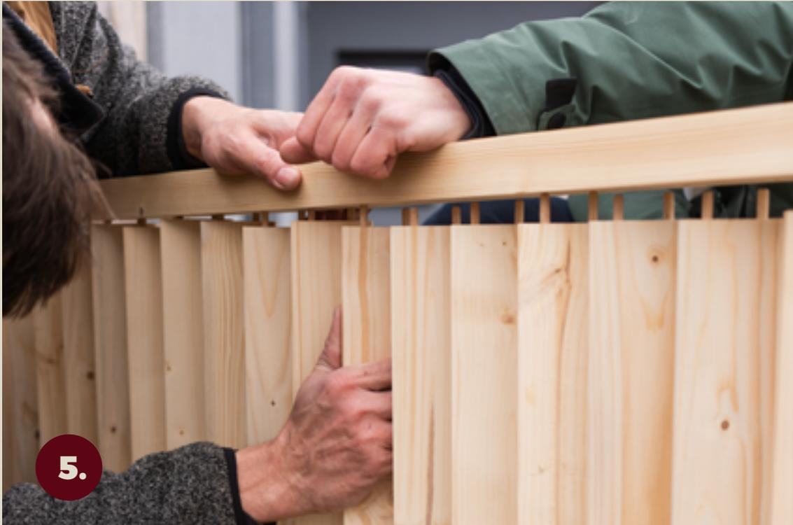
Fügen Sie die Lamellen nach und nach in die Löcher der oberen Seitenwand ein, eine nach der anderen, indem Sie sie leicht aus der unteren Seitenwand herausziehen. Stellen Sie durch Klopfen mit einem Holzstück oder Gummihammer sicher, dass alle Stifte vollständig in die Seitenwände eingeführt sind.
