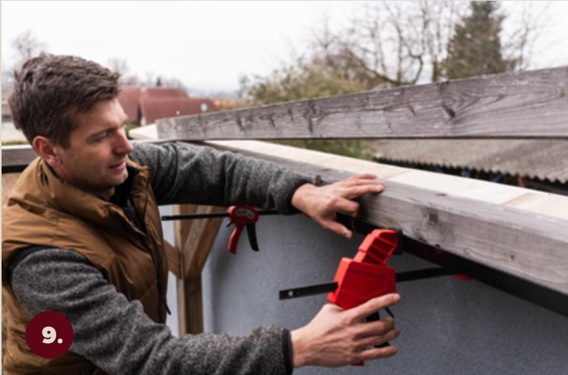
Beim Verbinden von zwei Schienen (sowohl geraden als auch Eckigen) ist die Verwendung einer Wasserwaage für einen reibungslosen Durchgang des Sonnenbrechers notwendig.
