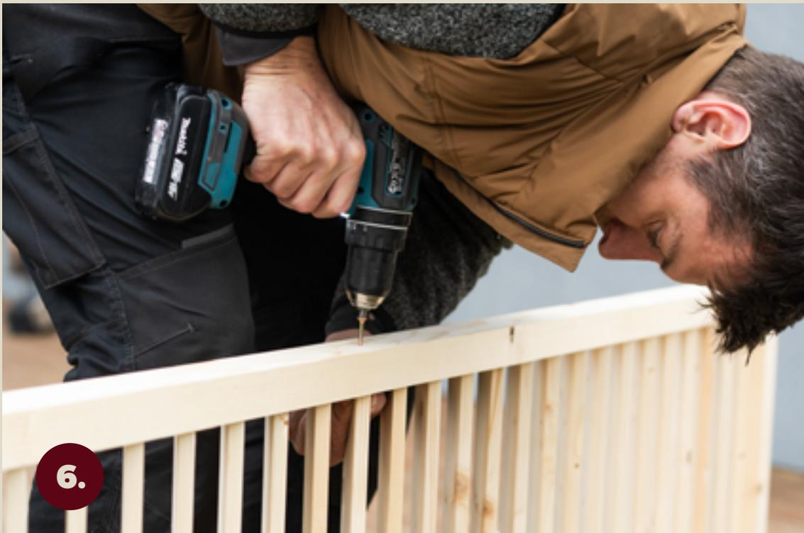
Sichern Sie die Lamellen mit einer Schraube in der Mitte und an den Enden der Seitenwände.
