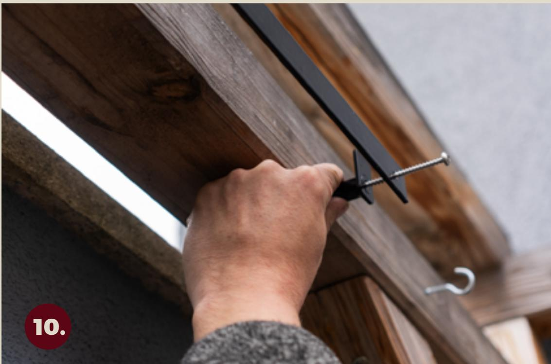
Setzen Sie den Sonnenbrecher ein. Sichern Sie die Enden der Schiene mit einem Endstück.
